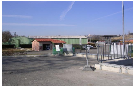
Lectoure (32700), Zone Industrielle
