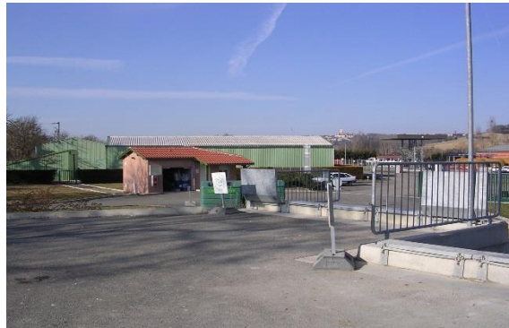
Lectoure (32700), Zone Industrielle
