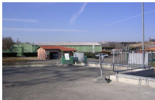
Lectoure (32700), Zone Industrielle
